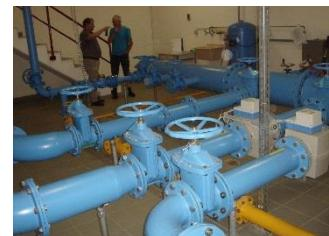
Reservoir Wilerholz, Murten: Bestehende Rohrinstallation. Hier ist der Einbau eines Stufenpumpwerks vorgesehen.
